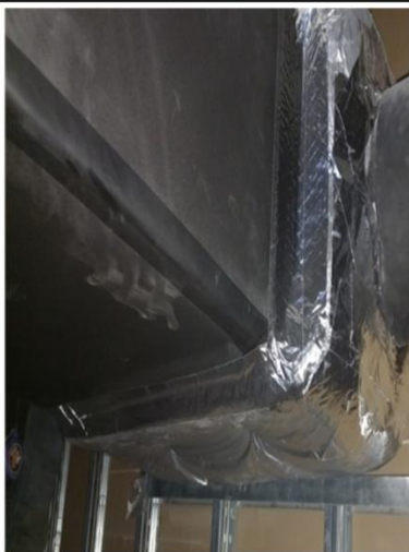
오성 마곡 상가 현장 시공
