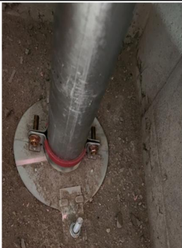
삼척 아파트 현장 시공
